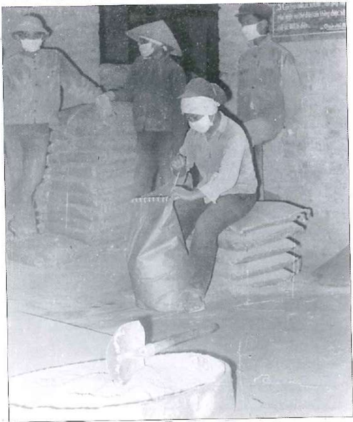
Bao xi măng đóng gói và cân trọng lượng bằng tay của công nhân
