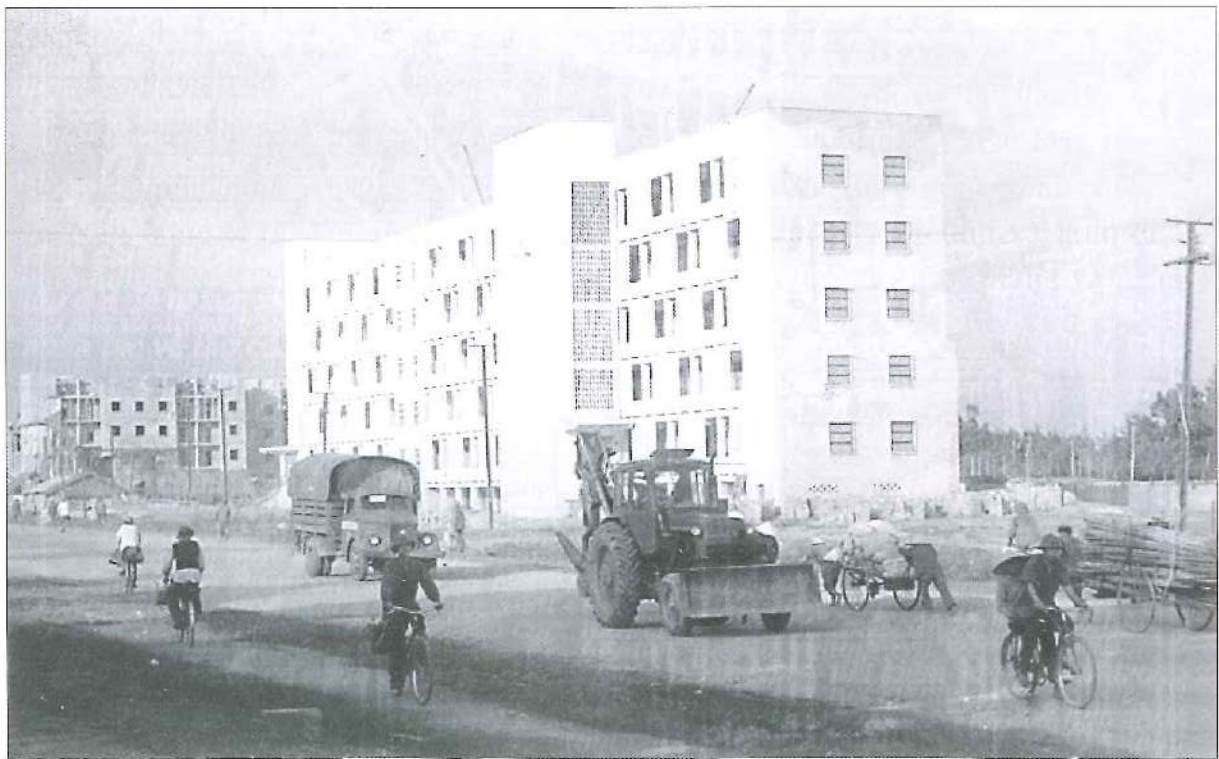
Các nhà cao tầng tiểu khu A đang xây dựng 1976 (A4-A5)
