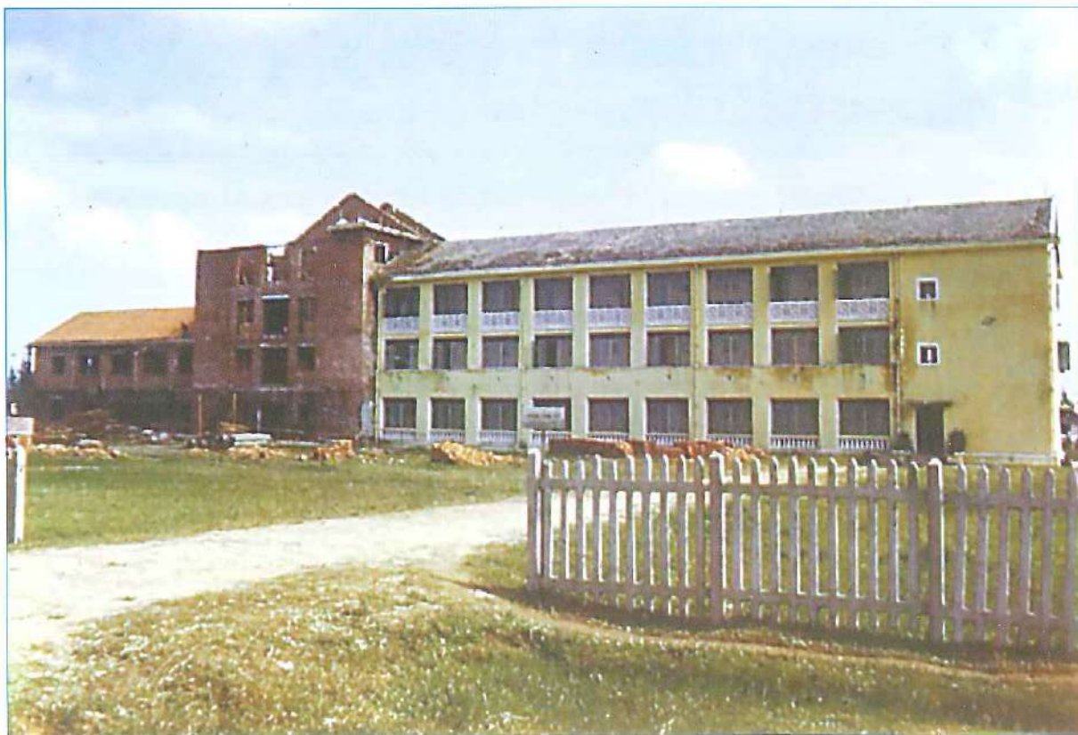
Nhà khách Giao tế 2 bị bom Mỹ phá hỏng đang được sửa chữa làm nơi ở và làm việc của các chuyên gia Đức đầu năm 1974
