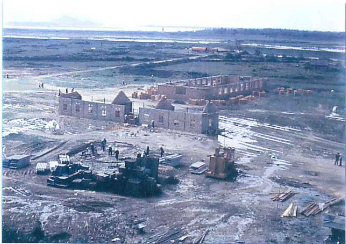
Khởi công xây dựng nhà máy bê tông đúc sẵn
