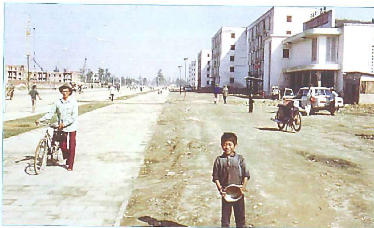
Các nhà cao tầng tiểu khu D (đối diện rạp 12/9) đang xây dựng dở dang (1979)
