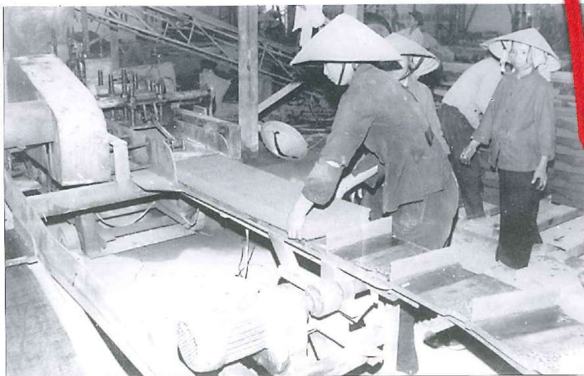
Công nhân XN đang vận hành máy cắt gạch mộc tự động do Đức viện trợ
