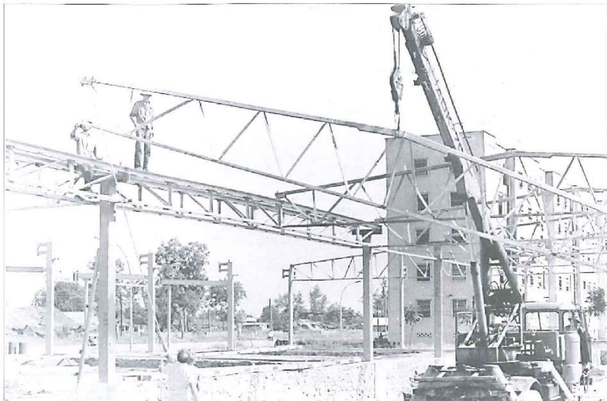
Cán cẩu ADK70 đang lắp khung thép xây dựng Nhà văn hóa thiếu nhi Việt - Đức
