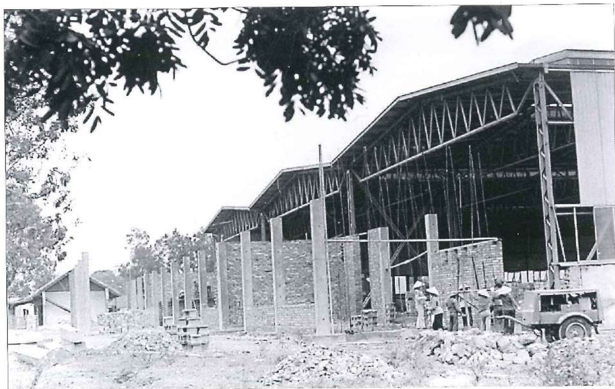
Một góc bên trái đỉnh chợ chính đang xây dựng
