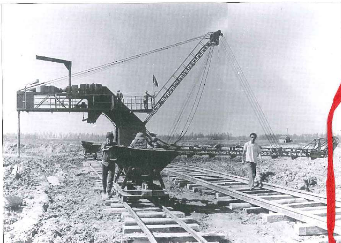
Máy đào đất đưa lên xe gòng vận chuyển về nơi sản xuất gạch do Đức viện trợ
