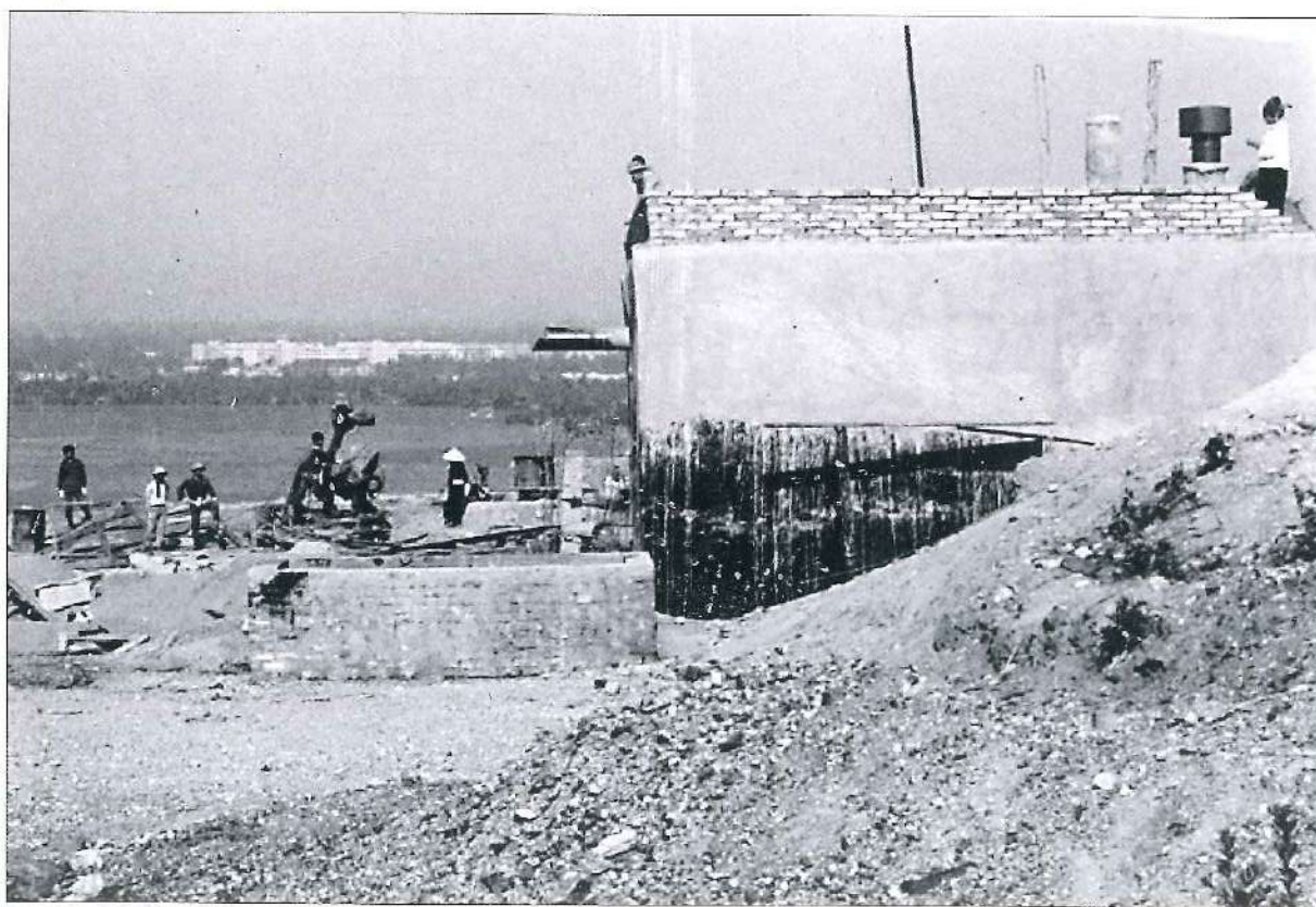
Bể chứa nước 3000m 3 cung cấp cho khu chung cư được xây dựng (1975)
