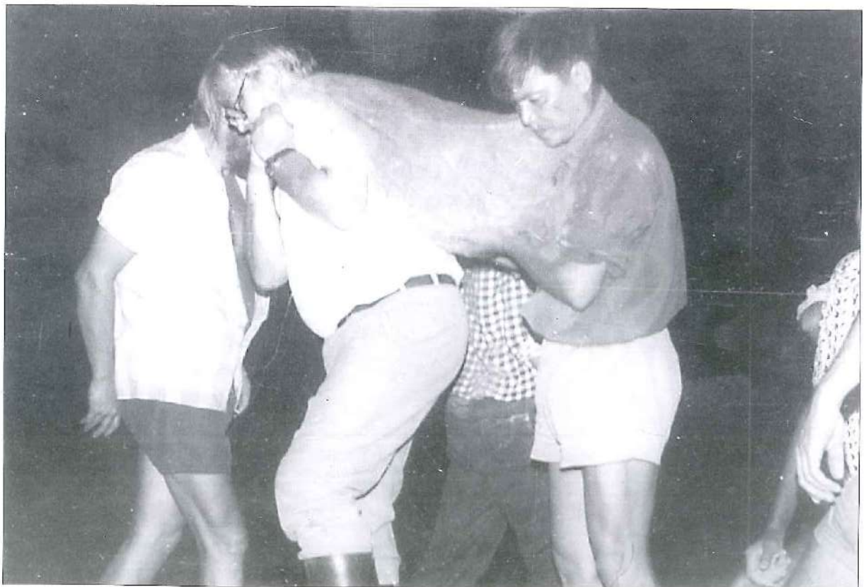
Ông Brambach và ông Trần Quốc Ban cùng các chuyên gia đang tham gia đắp bê tông lợp Bara Bén Thủy năm 1978
