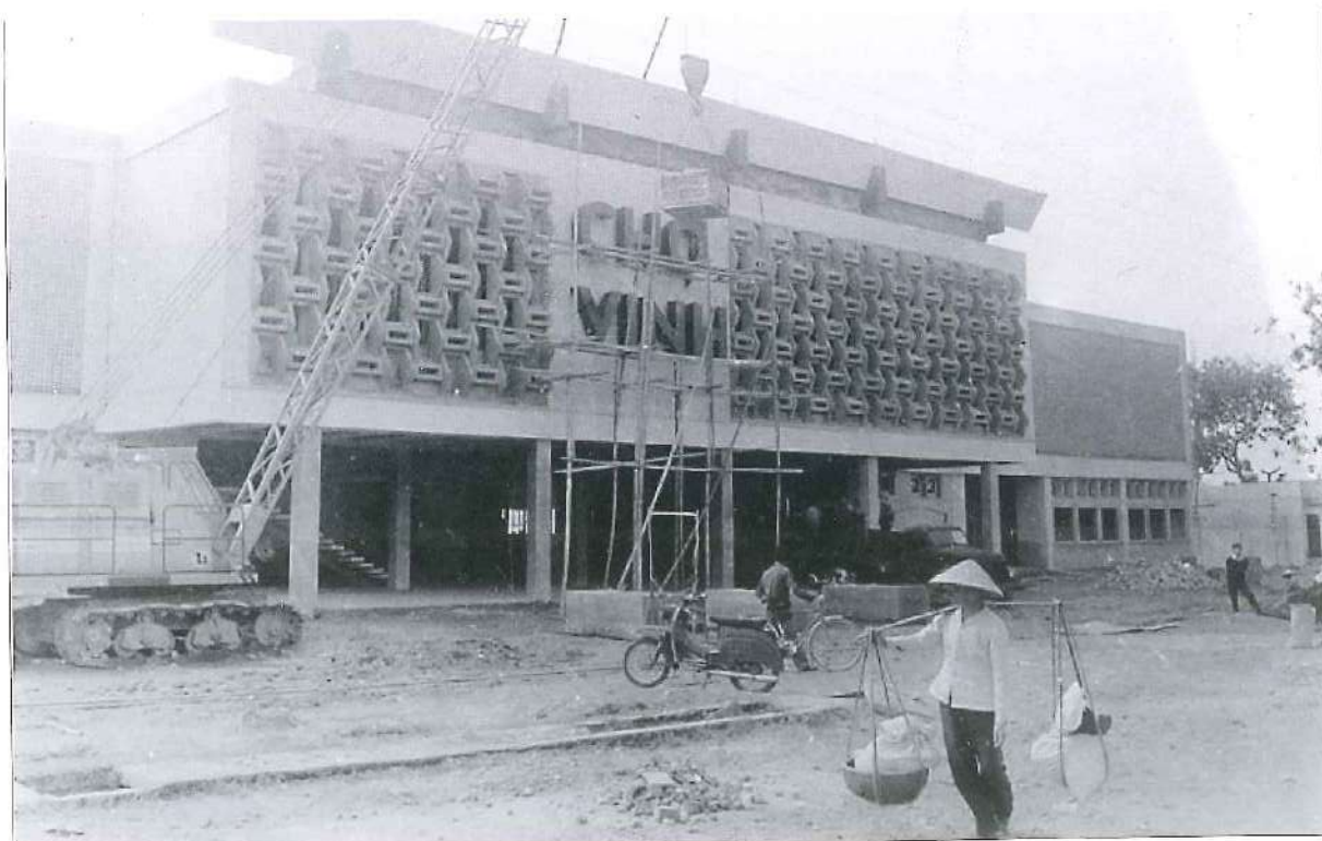
Nhà hai tầng mặt trước đỉnh chợ đang thi công
