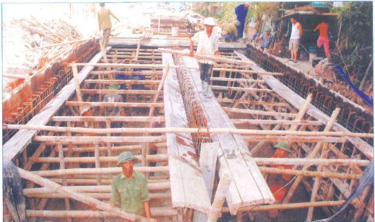
Mương thoát nước số 2, Cầu Thông - Vinh Tân nguồn viện trợ ODA đang xây dựng (ảnh chụp 7/2010)
