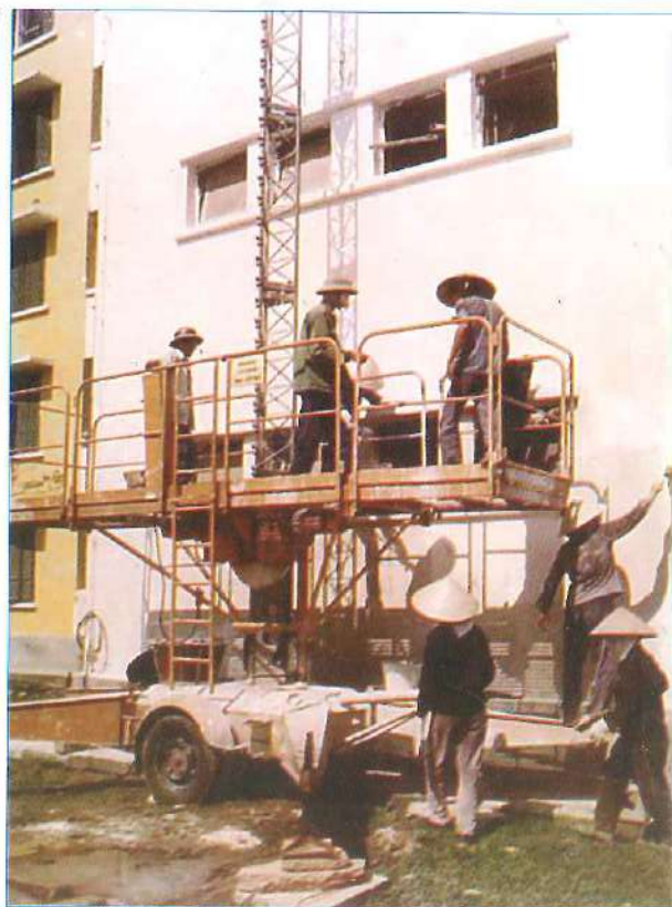
Nhà cao tầng tiểu khu C đang thi công bằng máy nâng FH-1600 và cần cầu tháp MB-88 hiện đại của Đức viện trợ (1977)
