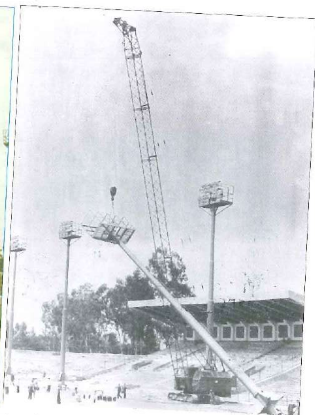
Khán đài A và hệ thống đèn chiếu sáng được chuyên gia Đức phối hợp thiết kế và xây dựng
