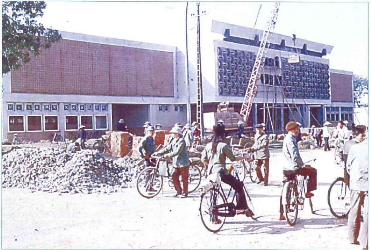
Nhà hàng, ki ốt hai bên nhà hai tầng mặt trước đình chợ đang thi công
