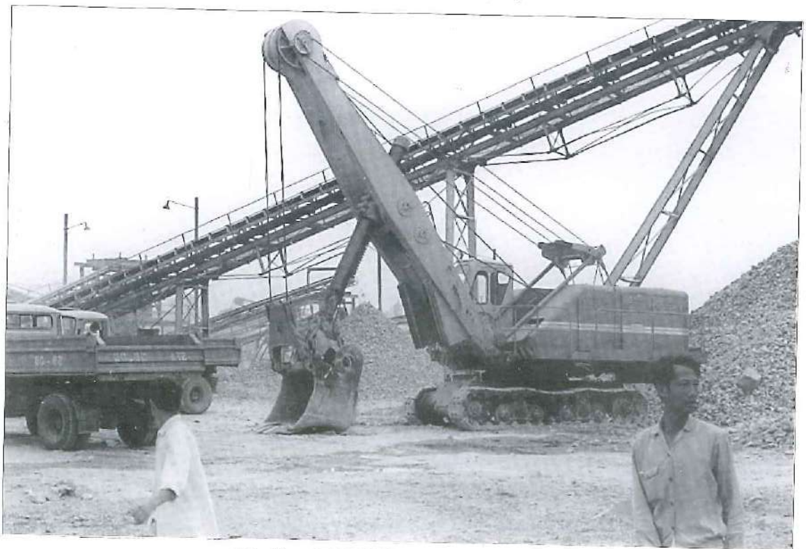
Máy đào, xúc UB 162 hiện đại đang hoạt động
