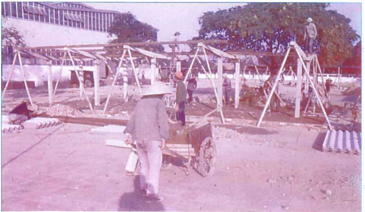
Các nhà khung bê tông, có mái che ở hai bên đình chợ chính
