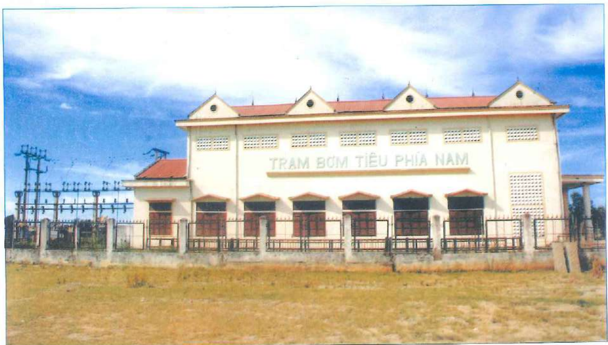
Trạm bơm tiêu úng phía Nam (ở Vinh Tân) 56.000m 3 /h được xây dựng bằng nguồn vốn chuyển đổi nợ của CHLB Đức (ảnh 7/2010)
