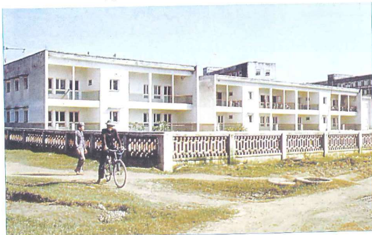
Nhà giữ trẻ phân khu A đã xây dựng xong, đưa vào sử dụng
