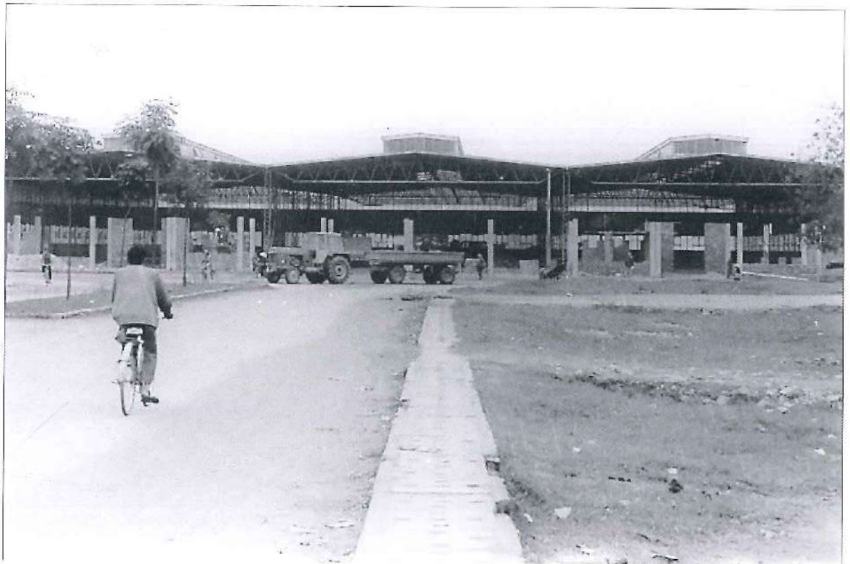
Đình chính chợ Vinh đang xây dựng
