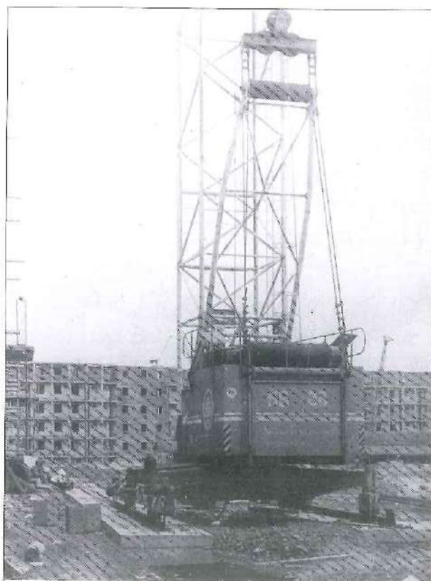
Nhà cao tầng tiểu khu C đang thi công bằng máy nâng FH-1600 và cần cầu tháp MB-88 hiện đại của Đức viện trợ (1977)
