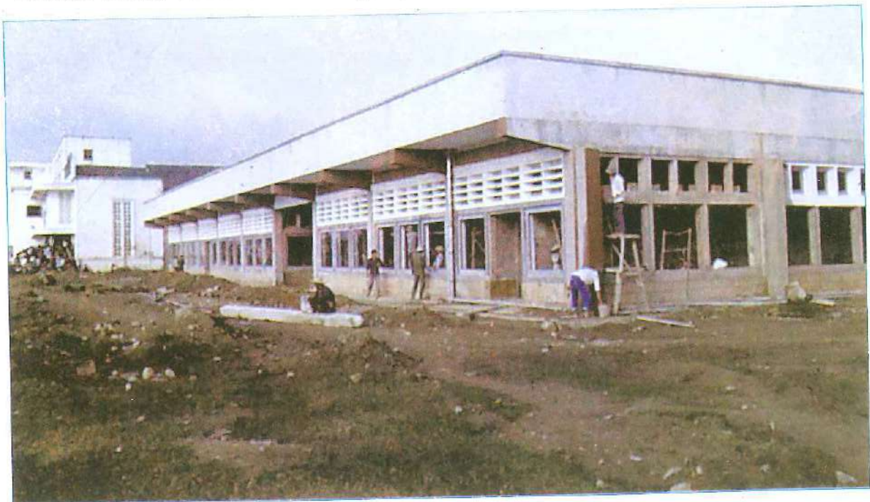
Khu thương mại Quang Trung đang được xây dựng
